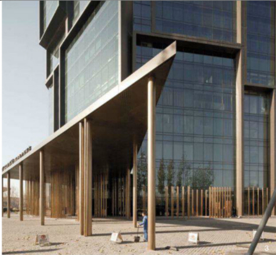
3. 多根銅桿支撐著兩個懸浮天蓬，引領訪客進入主入口。4. 西北向立視圖。5. 西向立視圖。6. 南向立視圖。7. 建築剖面圖。8.9.10. 中庭與露台。 3.A canopy supported by several copper columns give a direct hint of entrance ©Pegenaute 4.W.-N. side elevation 5.West elevation 6.South elevation 7.Section 8.9.10.Courtyard and balcony views©Pegenaute
